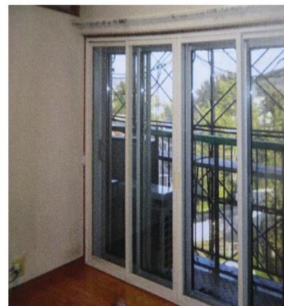
外窓工事後（4枚引き）
