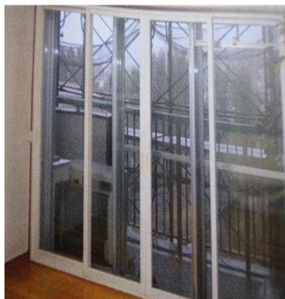
外窓工事前（3枚引き）
