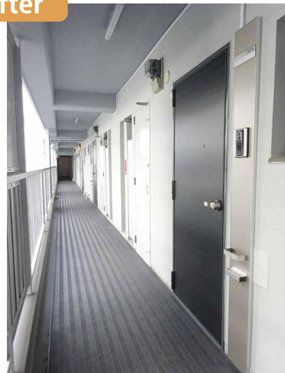
半間接照明と廊下、玄関まわりの改修
