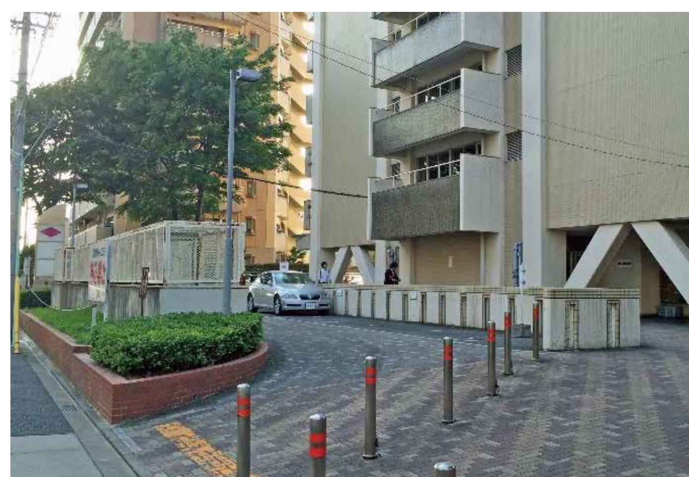
沿道部にゴミ置場が露出
