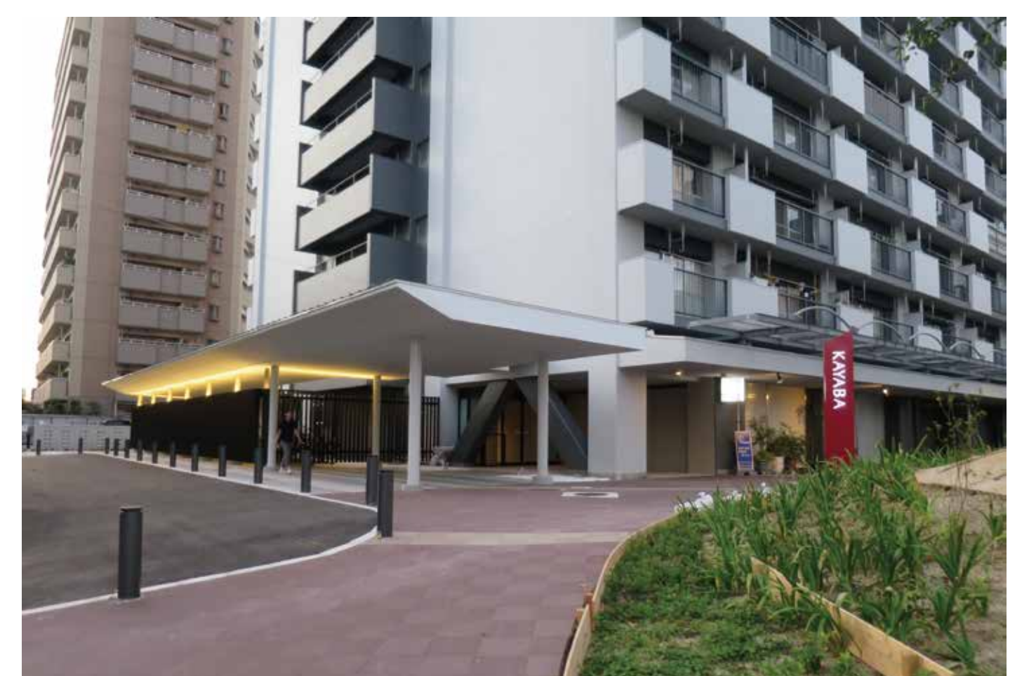
ゴミ置場を移設し、車寄せとキャノピーを設置
