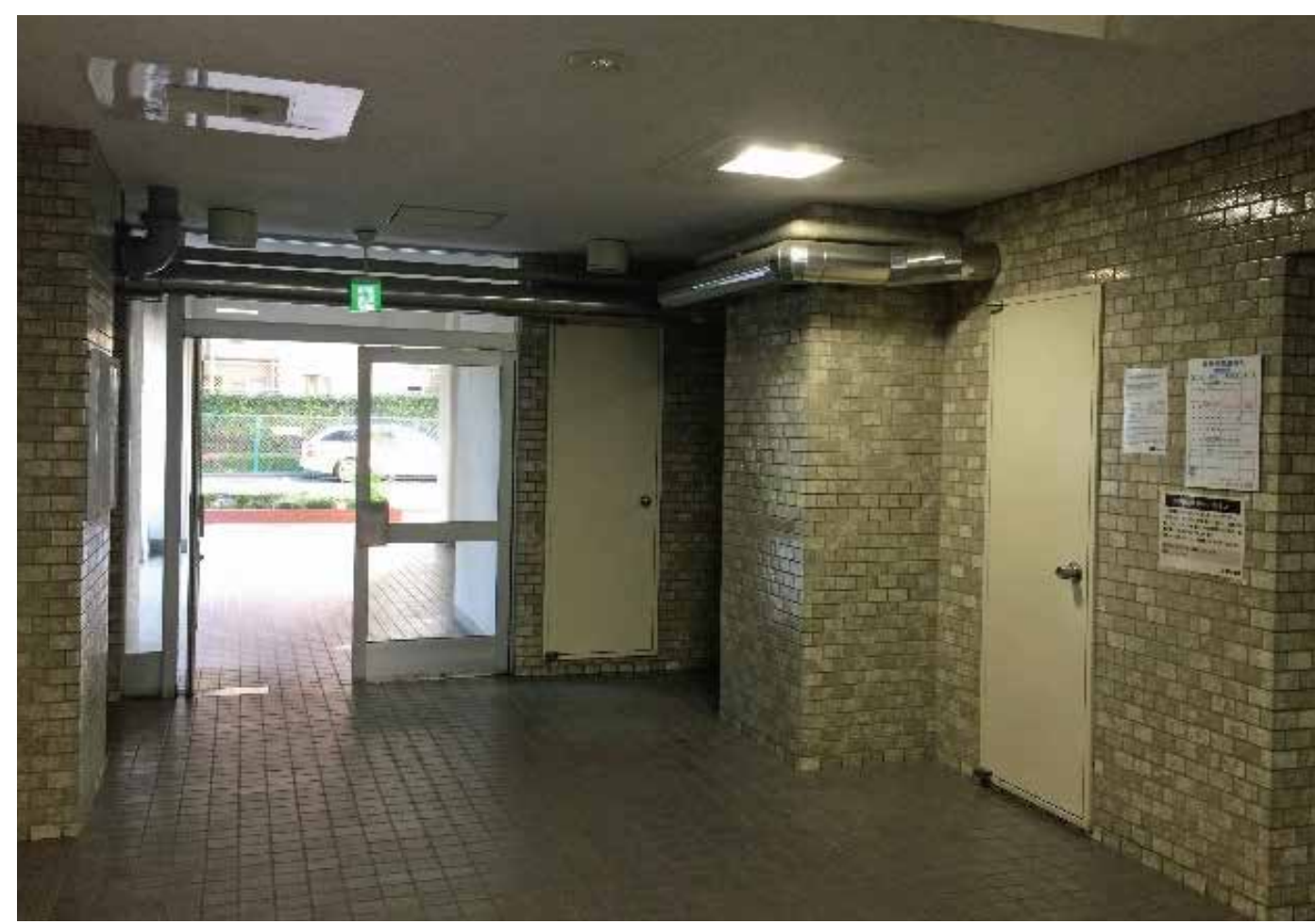
配管むき出しで寒々しい玄関ホール
