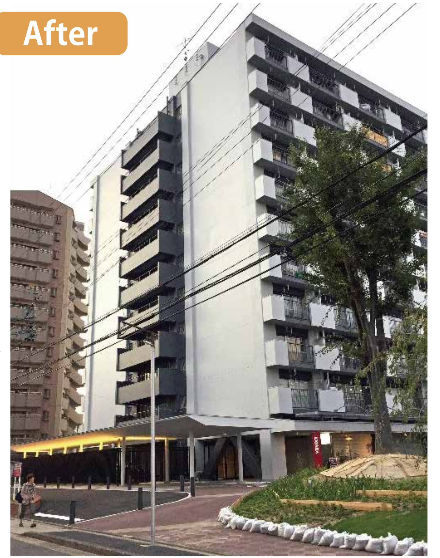
実施後の様子
