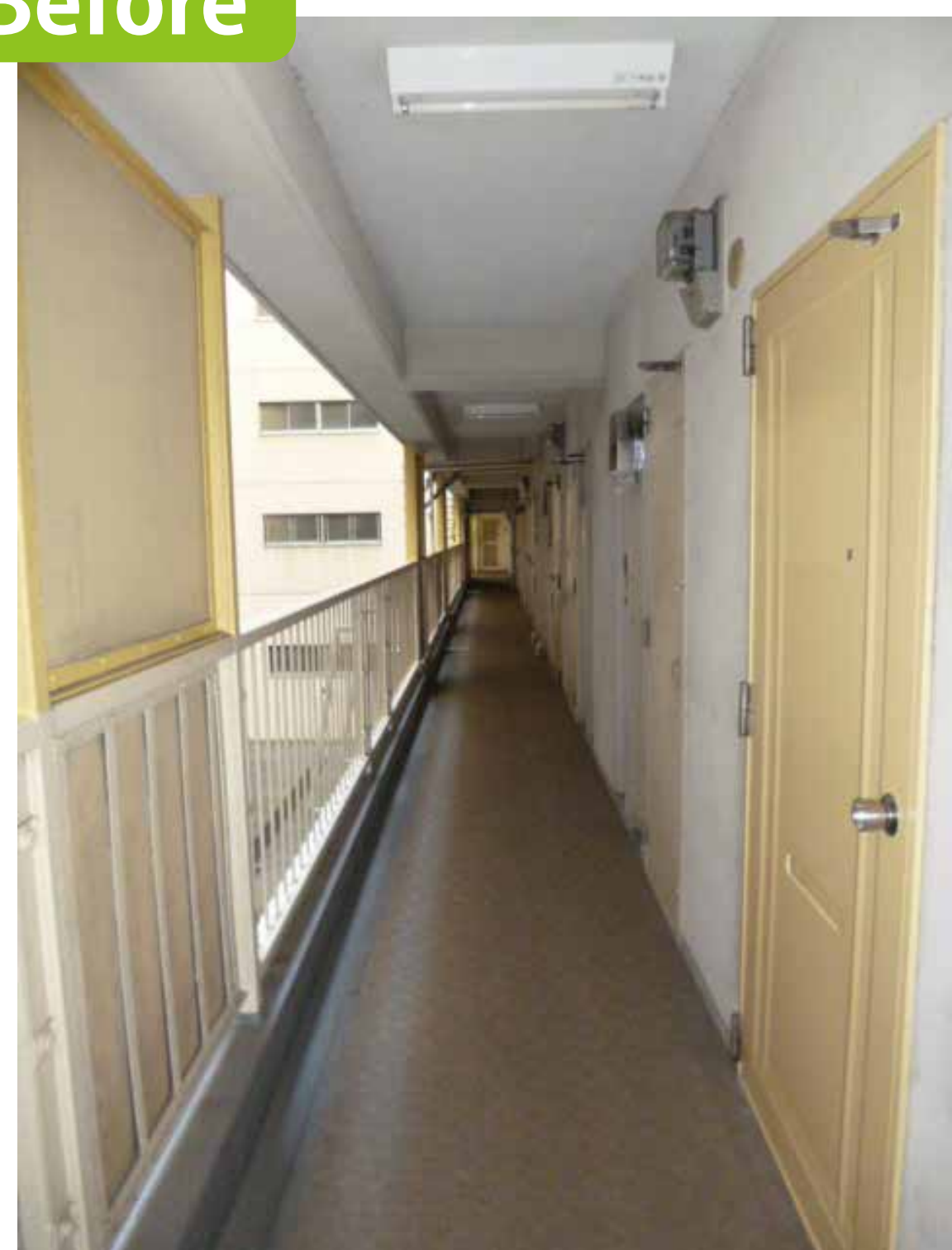
古びた共用廊下と玄関前
