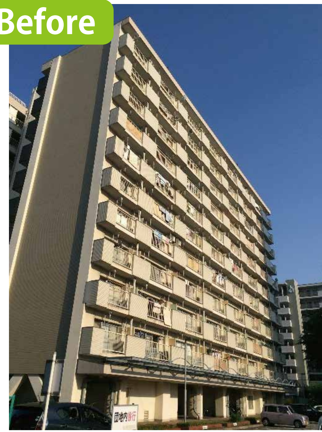
実施前の様子（萱場団地）
